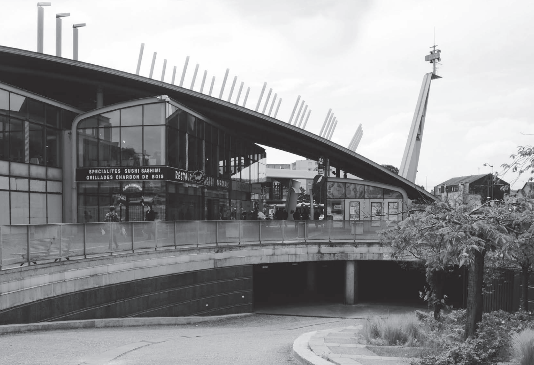
Alessandro Anselmi, esterno nord del Centro commerciale di Sotteville-Lès-Rouen, Francia, 1993-1995. Ph. Alessandro Brunelli, 2016
