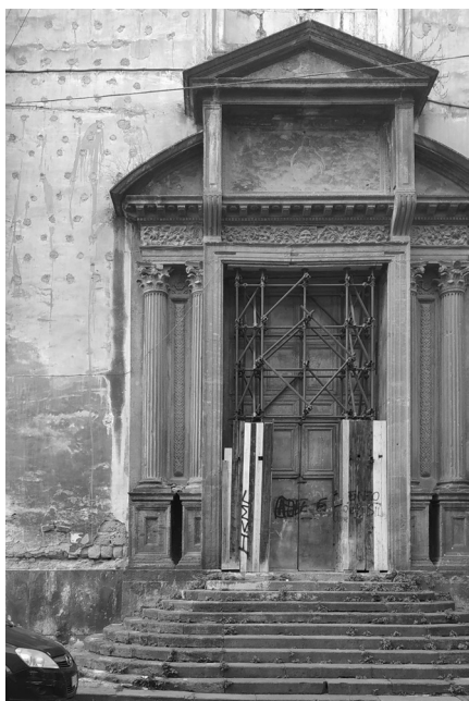
27. S. Maria delle Grazie a Caponapoli Fondo Edifici di Culto Chiusa (in restauro)
