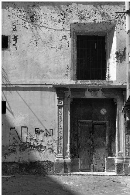
10_ S. Maria dell'Arco ? Deposito
